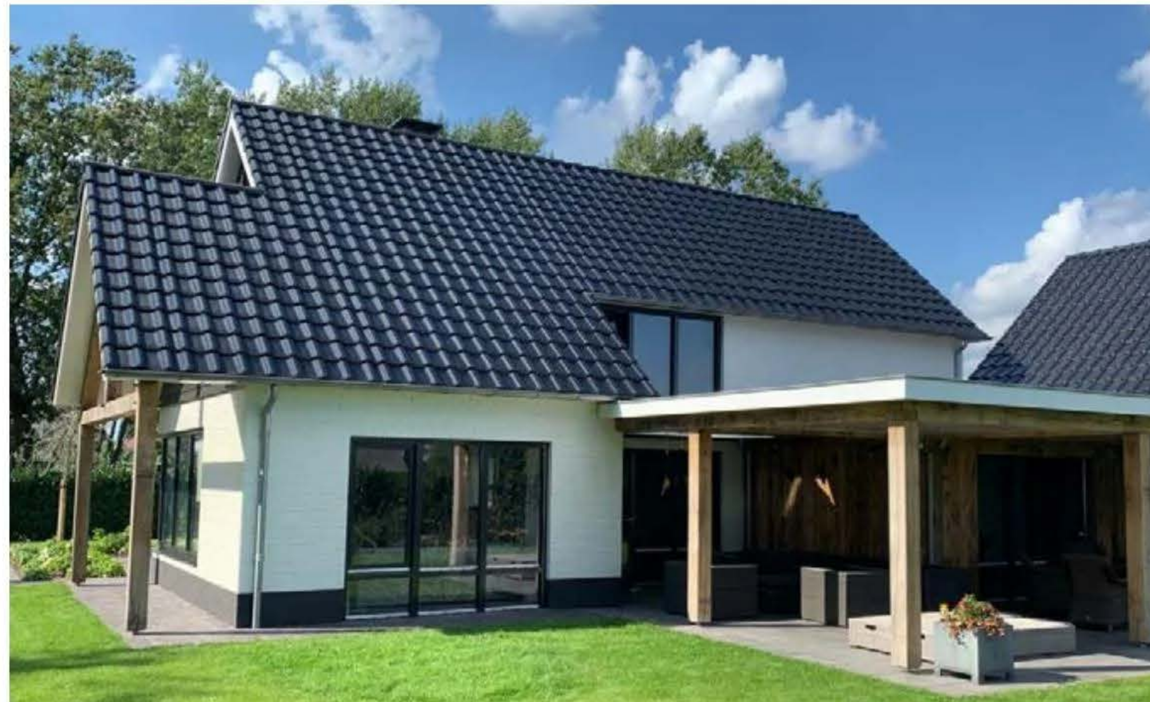
Renovatie jaren 60 woning
