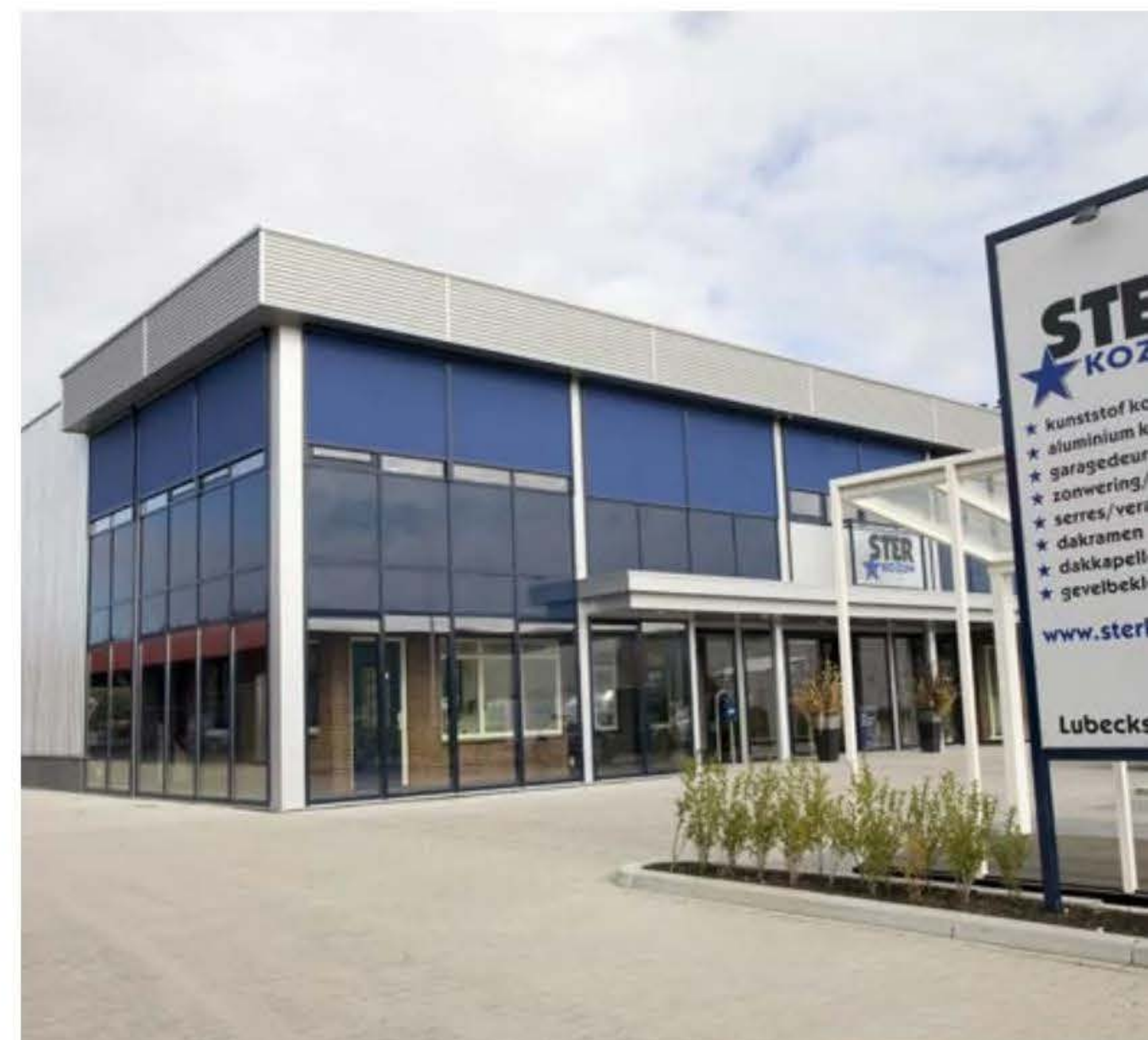
Nieuwbouw bedrijfspand Ster Kozijn
