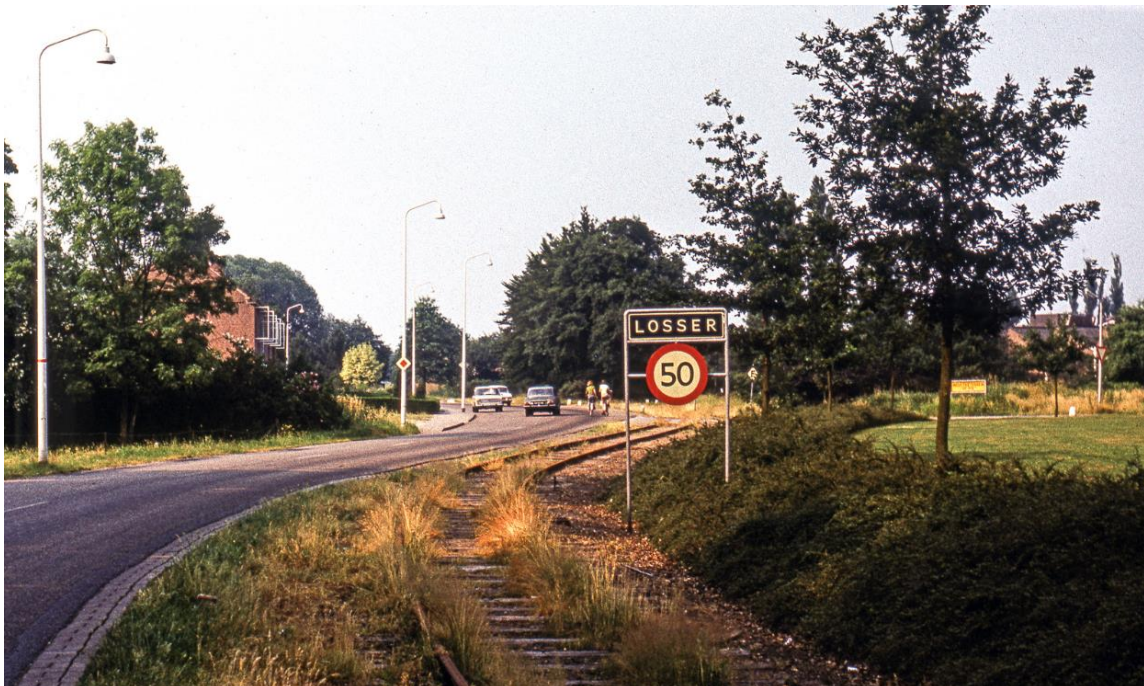
Afbeelding 3.1 – De al buiten dienst gestelde spoorlijn Glanerbrug – Losser bij het inrijden van de bebouwde kom van Losser in 1973. (Wiskerke)
